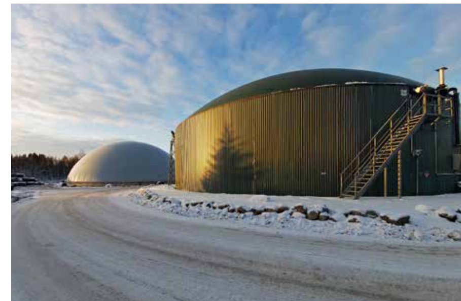
Laitoksen biokaasureaktorista tulee suurin piirtein samankokoinen kuin tämä Jepualla toimiva reaktori. Taustalla on katettu mädätysjäännössäiliö.
